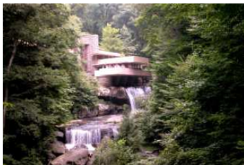
Maison sur la cascade
